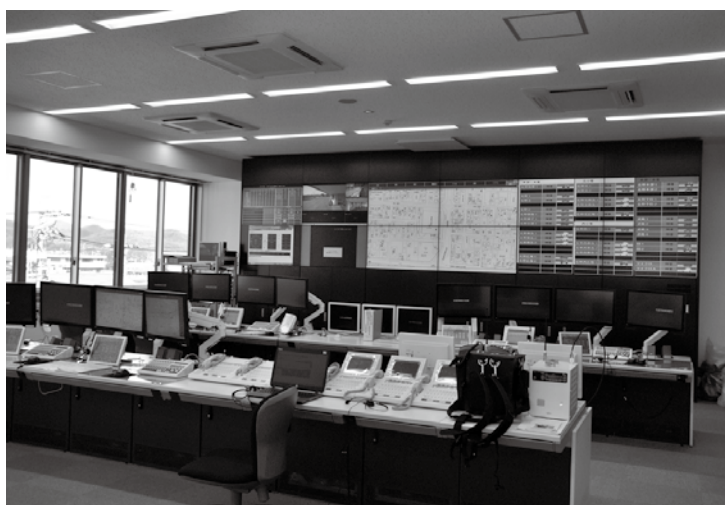
中央に市内全域の地図を表記し、各消防車・救急車の出動状況を管理する高機能指令センター
