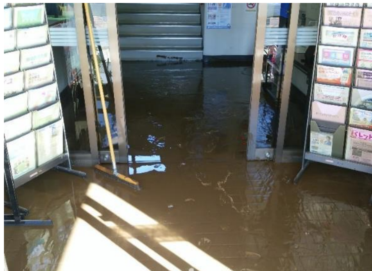
隣保館（館内床上浸水）
