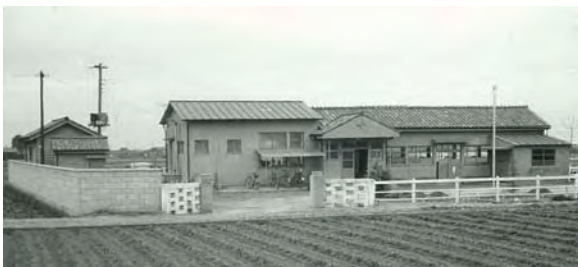
旧田沼町水道庁舎
